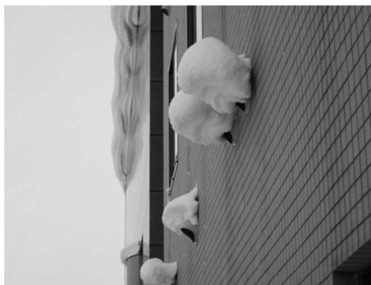
図1 換気口への着雪(倶知安)
