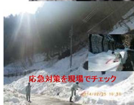
図 5 雪崩危険箇所点検と応急対策(山梨県 2/25)
