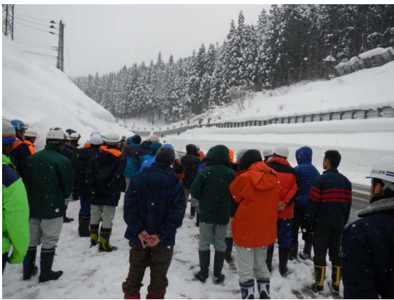
写真2 斜面雪処理現場での作業方法の説明。
