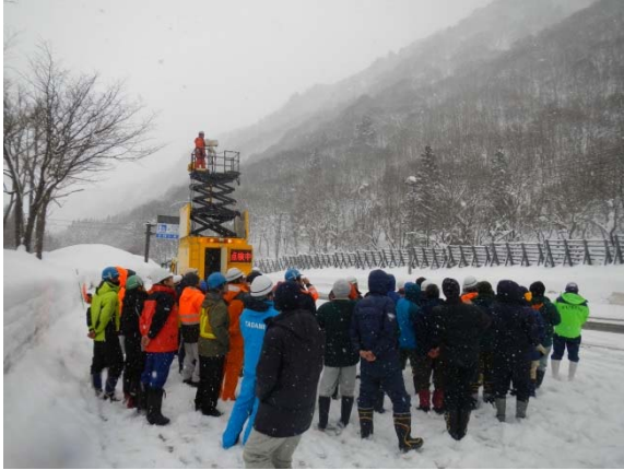
写真1 法面点検車と斜面監視の解説。
