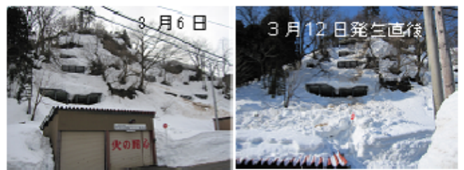
図 5: 十日町市小出地区雪崩発生状況 (小出地区 区長さん撮影)
