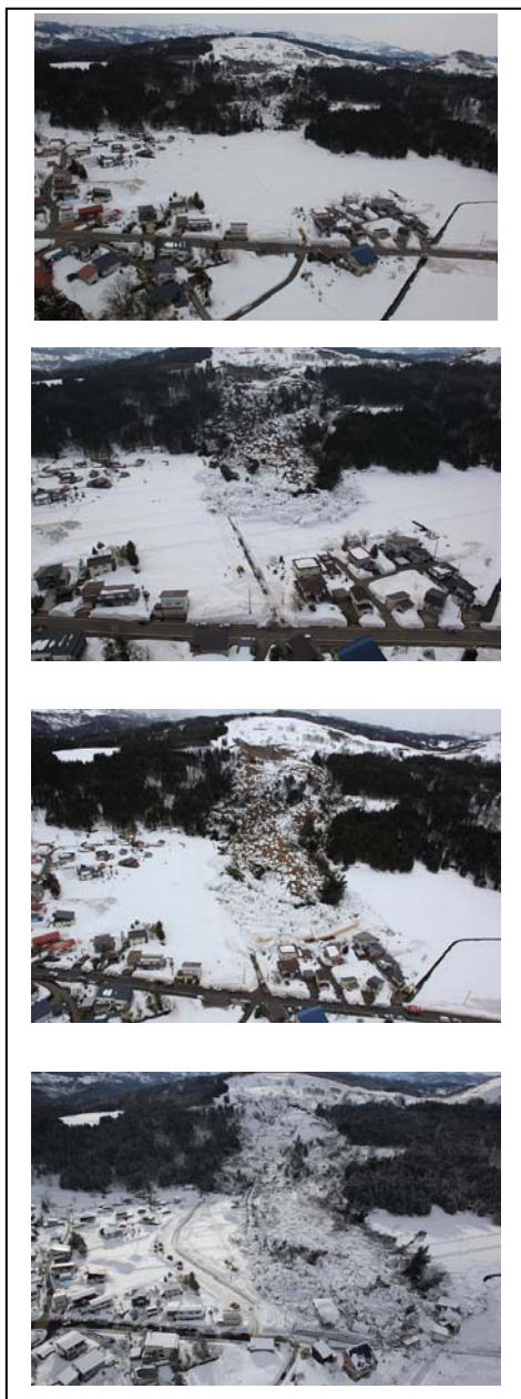
写真1 上から3月8日、9日、10日、13日の状況 （提供：新潟県）
