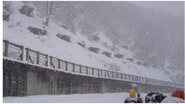
写真2 雪崩危険斜面の判定、雪崩管理の現地実習（撮影：山田紘士）
