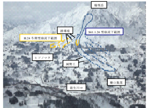
図 4: 糸魚川市柵口地区における雪崩発生状況
