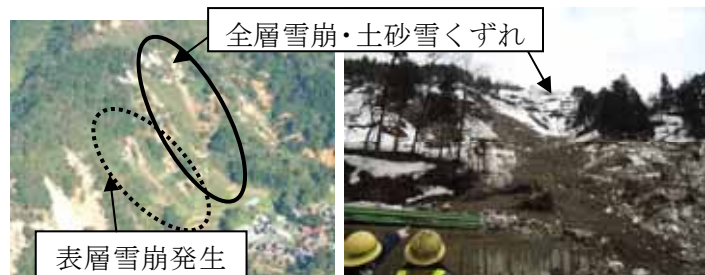
図 2.1 中越地震による表層崩壊と雪崩発生(長岡市濁沢地区)
