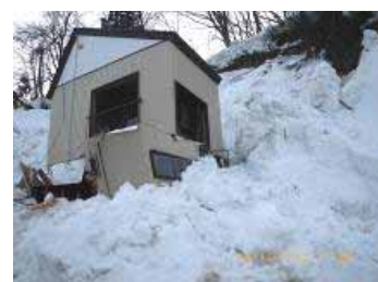
図 3.3 地震による雪崩によって被災した建物(新潟県十日町市)
