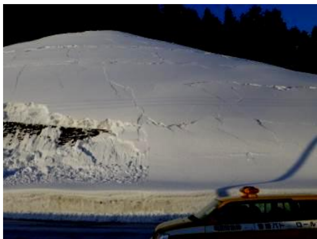
写3 地震により発生した網目状クラック
