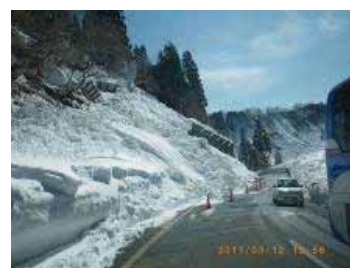
図 3.4 雪崩予防柵を乗り越えて道路埋雪(新潟県十日町市)
