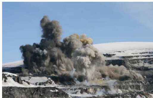
図3 ベンチ発破の状況
