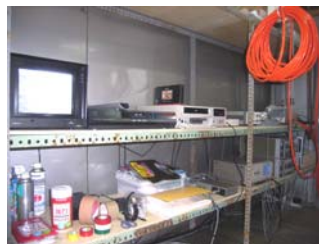
観測小屋内部
