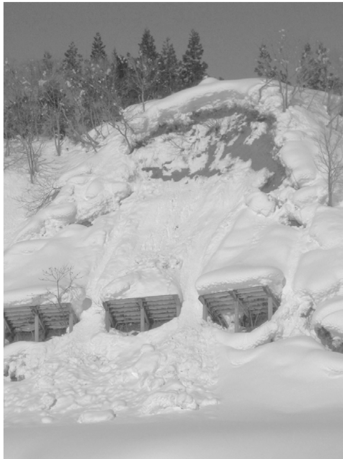
19年ぶりの豪雪により雪に埋没してしまった雪崩予防柵 (2005年1月19日 新潟県魚沼市守門で山口悟会員撮影)
