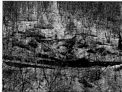
写真-2 雪崩Bの被災状況
