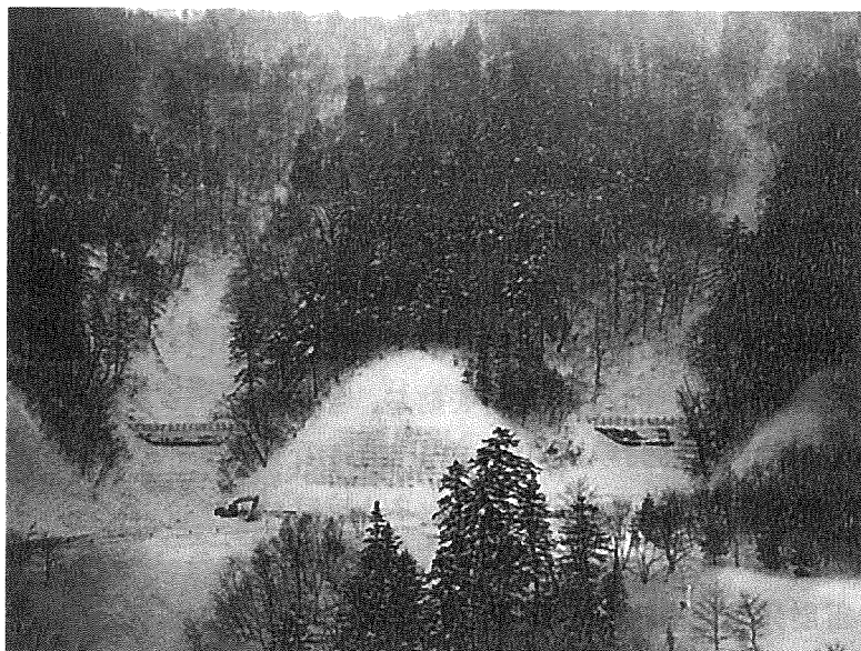
図3 雪崩の発生した沢と防護擁壁(1999年3月4日撮影)
