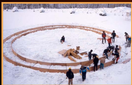
雪氷基礎リングの施工
