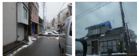
図 3 道路上への建物の倒壊と屋根上に設置されたブルーシートの状況 (石川県七尾市)
