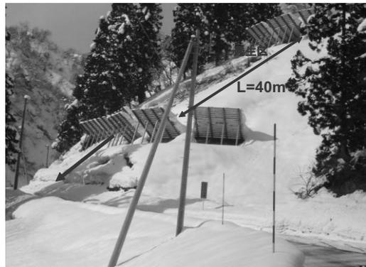
図 4 一村尾地区での雪崩 (一部柵間をすり抜けている)
