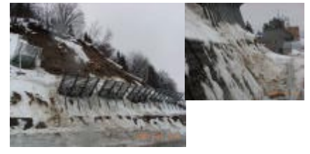
図2 予防柵上部からの雪崩と雪堤による防護
