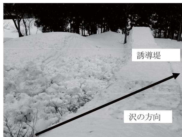
図-2 誘導堤で停止した雪崩
