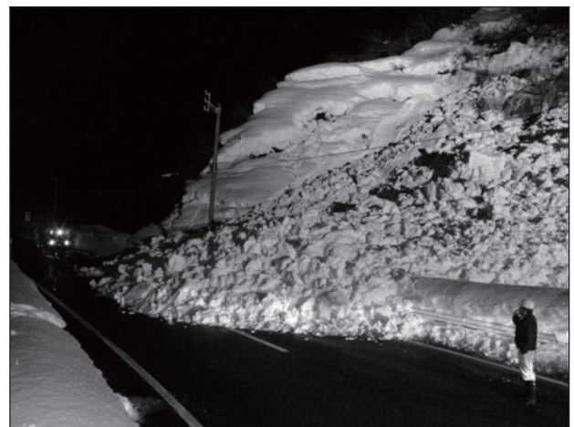
写 1 国道 252 号上稲倉地区 被災状況
