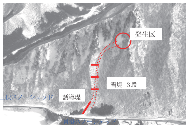
図-1 雪崩発生斜面と流下阻止対策工
