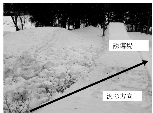
図-2 誘導堤で停止した雪崩
