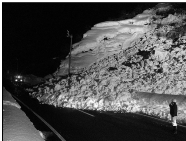
写 1 国道 252 号上稲倉地区 被災状況
