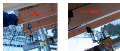
図4: たわみセンサーを軒先（左）、屋根中央（右）に設置したところ
