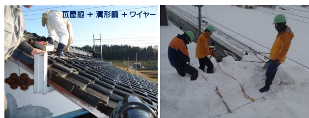
図2 ワイヤをつかったアンカー施工と除雪作業
