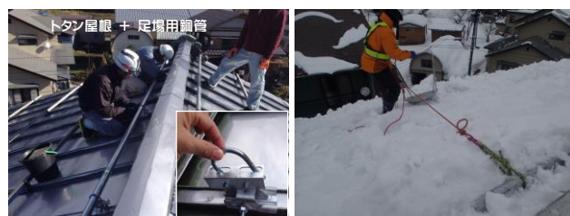
図1 足場用鋼管をつかったアンカー施工と除雪作業
