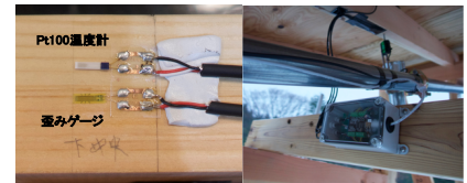
図2: 歪み測定用の歪みゲージ（左）と計測器と共に垂木に設置したところ（右）
