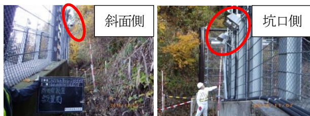
写真1 降雪前の設置状況
