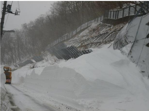
写真-1 雪崩発生後の防雪施設の状況 (2月16日)
