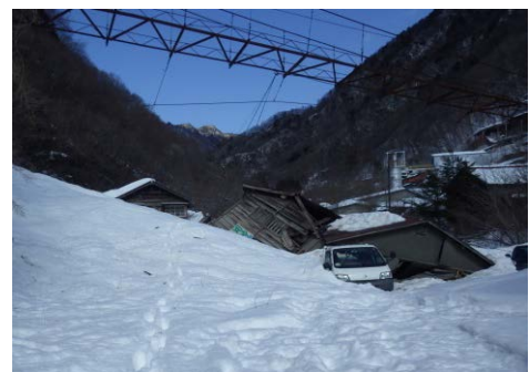
図 2 秩父の事例における被害状況
