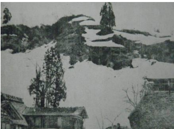
図 1 十日町市大池の切取階段工 (高橋, 1952)
