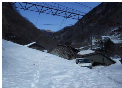
図 2 秩父の事例における被害状況
