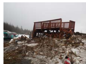
図12 富士スバルライン 雪崩被害(3/19)
