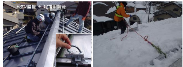
図1 足場用鋼管をつかったアンカー施工と除雪作業
