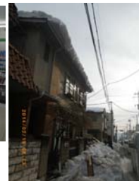
図5 甲府市屋根雪崩落の危険性
