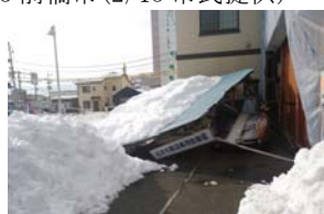
図6 甲府市駐車施設倒壊
