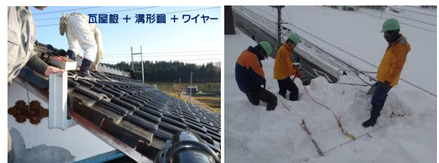
図2 ワイヤをつかったアンカー施工と除雪作業
