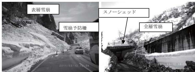
図2 地震によって発生した表層雪崩・全層雪崩(十日町市、津南町)
