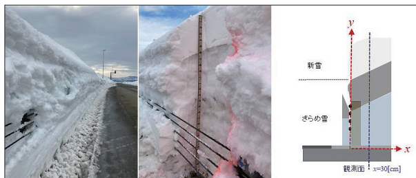
図4 高速道路の雪堤断面の例 ③
