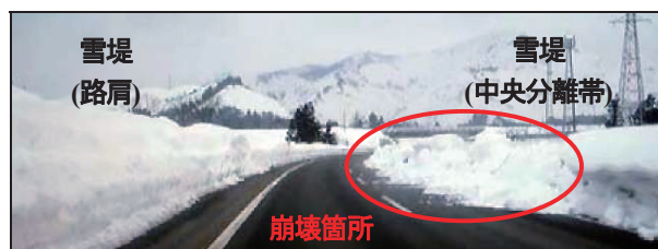
図1 大規模な崩壊現象で車線が塞がれた関越自動車道 [1]
