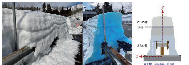
図3 高速道路の雪堤断面の例 ②
