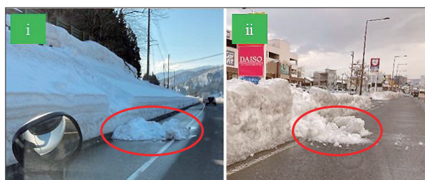
図10 「滑り型」雪堤崩壊の例
