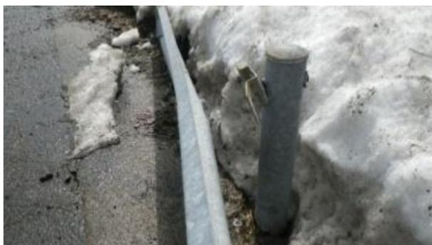
写真1 ガードレールの脱落事例<sup>[1]</sup>
