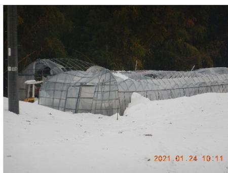
図2 ビニールハウスの倒壊(上越市)
