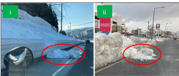
図10 「滑り型」雪堤崩壊の例
