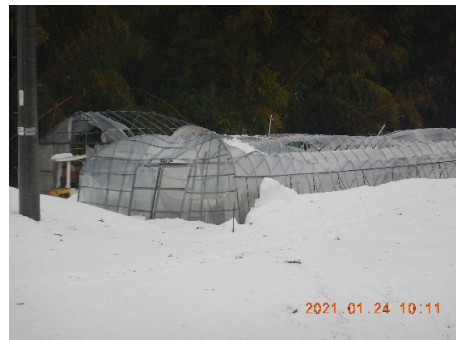
図 2 ビニールハウスの倒壊(上越市)
