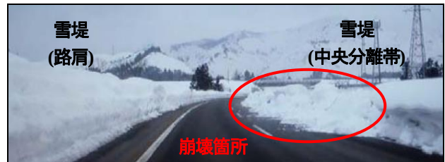
図1 大規模な崩壊現象で車線が塞がれた関越自動車道 1)
