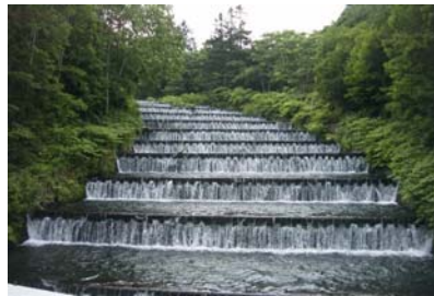
奥沢水源地水道施設
