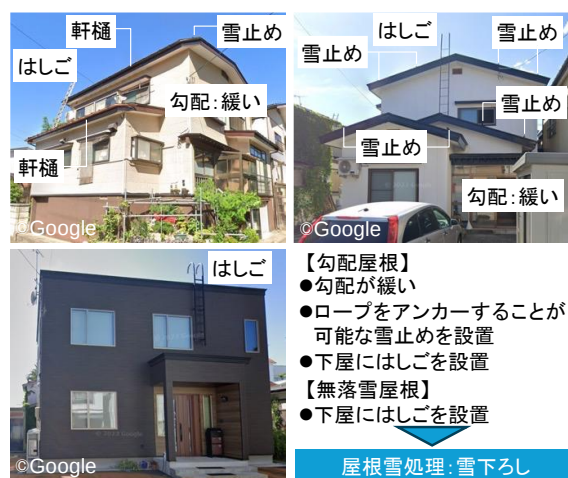
図7 屋根雪処理の考察 (秋田県横手市)
