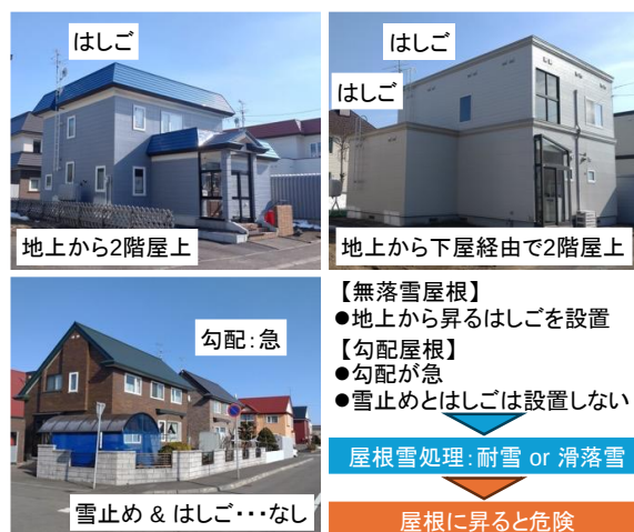
図6 屋根雪処理の考察 (北海道札幌市)
