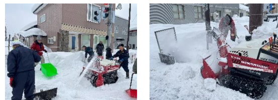
写真2 除雪機による機械投雪（右写真中の長方形の衝立が機械投雪補助具）
