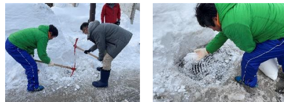
写真1 （左：投雪口の掘り起こし 右：凍結防止剤の散布）
