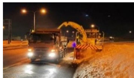
図13 夜間通行止め時の排雪作業
