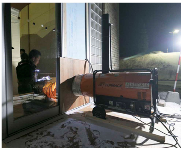
写真6 熱交換式ジェットヒーター
