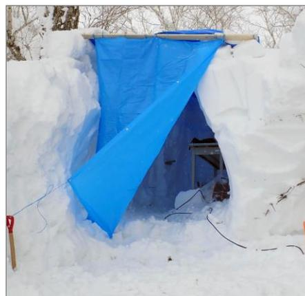
図1 雪洞（撮影室）の制作。上：積雪の掘り下げとブロックの積み上げ。下：ブルーシートにより冷却を促す天井と入口。
