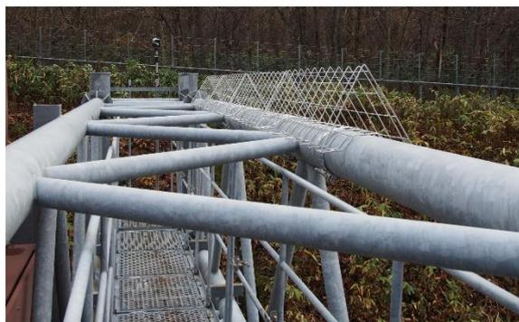
図5 格子フェンスの道路情報板への設置状況
