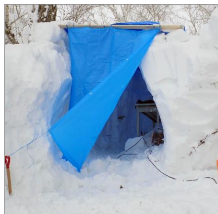
図1 雪洞（撮影室）の制作。上：積雪の掘り下げとブロックの積み上げ。下：ブルーシートにより冷却を促す天井と入口。
