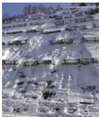
図3 点発生湿雪表層雪崩（道路雪崩）
