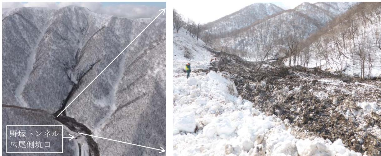
図5 野塚トンネル広尾側坑口と雪崩が発生した沢 (3本の沢の内、中央の沢)、同トンネル坑口上部の雪だけのデブリの壁が土砂を含むデブリを豊似川方面へ流した。
