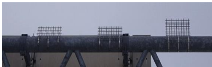
図 3 格子フェンス設置状況
