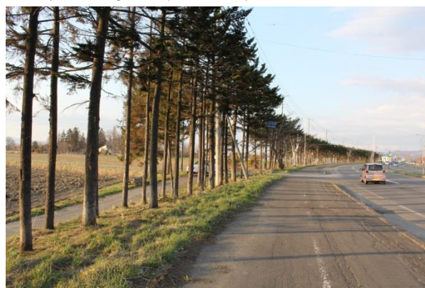
写真 4 下枝が高く枯れ上がった道路防雪林
