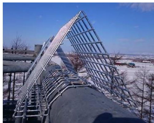
図 2 頂角 60^\circ の格子フェンス
