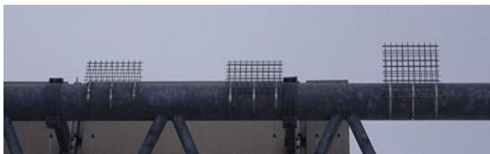
図3 格子フェンス設置状況
