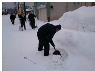
図 6. 流雪槽を掘り当てる
