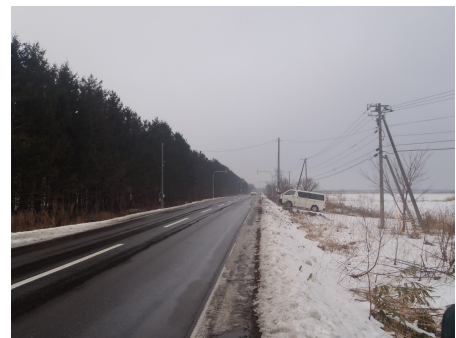
図 1 道路防雪林(天塩町)
