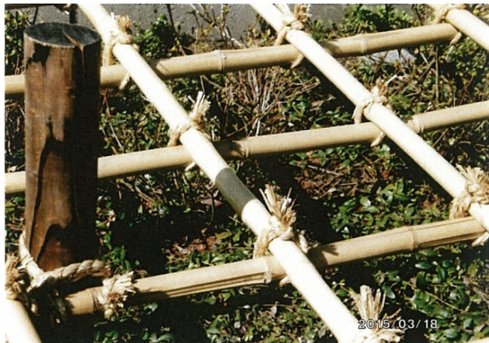
写真6 竹と木杭と縄による、匠の技 常緑性の小低木類に適する
