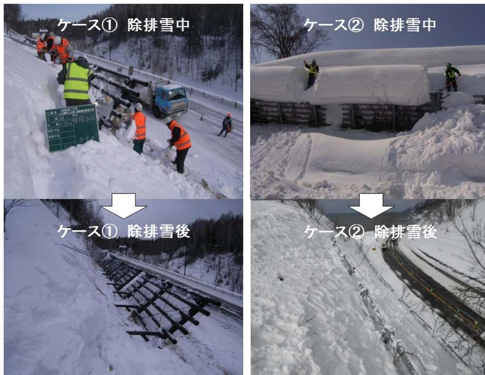
図2 雪崩予防柵の設置箇所における法面除排雪の事例
