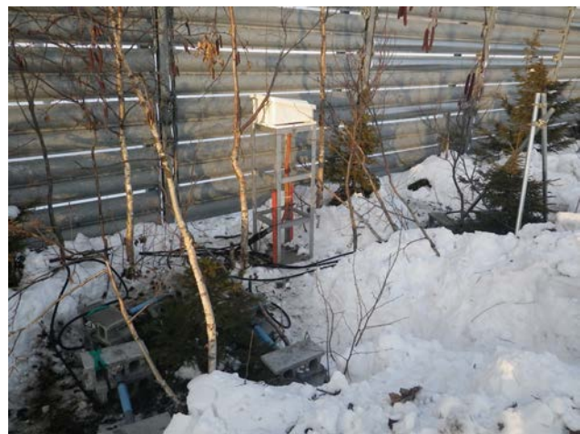
図 2 パイプひずみゲージ等の設置状況
