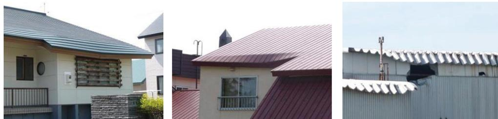
写真 1 豪雪後における軒部損傷の事例
