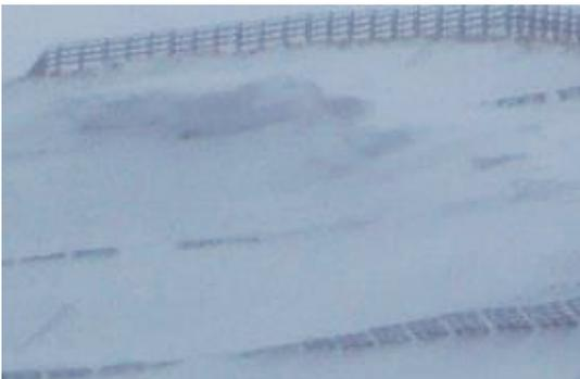
だまりが雪庇状に成長した例が写真4. である。雪崩柵を大きく埋め尽くしたのは柵で吹き払われた雪が吹きだまりとなったものである。これと隣接した切土斜面では同じような吹きだまりが崩落し雪崩となっている。乾き新雪による吹きだまりや雪庇は密度も強度も小さいので破断・崩落することがある。
