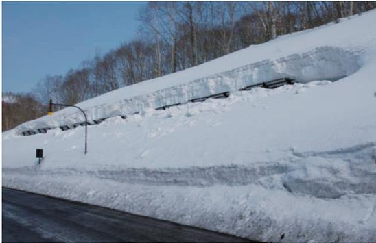
雪庇のはみ出した部分が平均気温0℃の暖気が5日間続いて破断した例である。破断した部分を除くと雪崩柵で支持されているので、写真2. の斜面積雪の除雪の必要性は小さいと考えられる。融雪期にみられる雪庇の破断は雪崩柵に懸かる雪庇が大きくはみ出して残っている場合にみられるが、一般的には雪庇の表面から剥離して小さくなり大きな塊で破断することは少ない。
