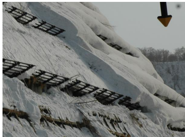
写真2. 雪庇と斜面積雪の除去
