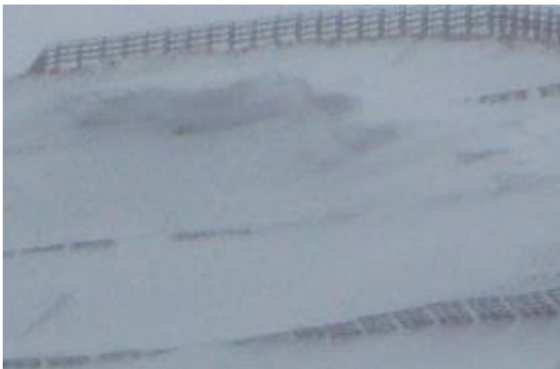
写真4. 雪庇防止柵の下の吹きだまり
