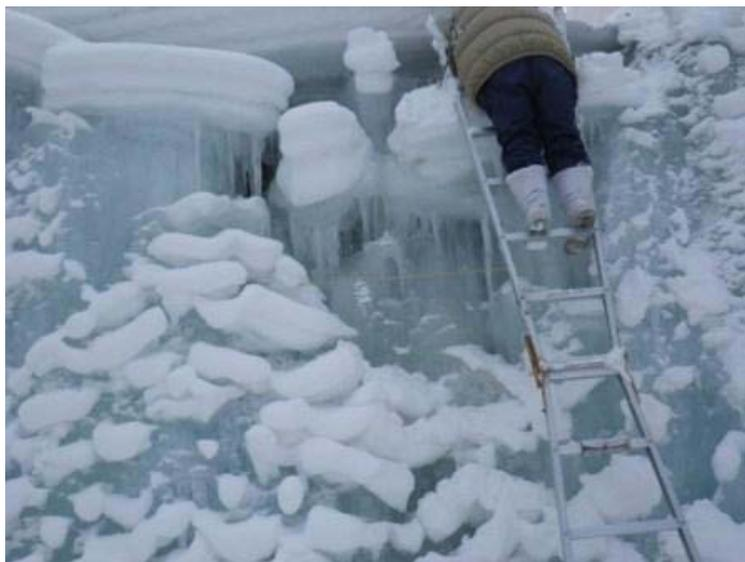
図-1 濁川ダム堤体の氷瀑。波状の付着積雪と成長したくらげ氷。2012年2月17日
