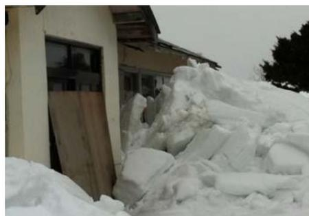
図-8 屋根雪による空き家の破損
