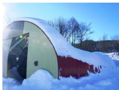
図-10 D型ハウスの被害
