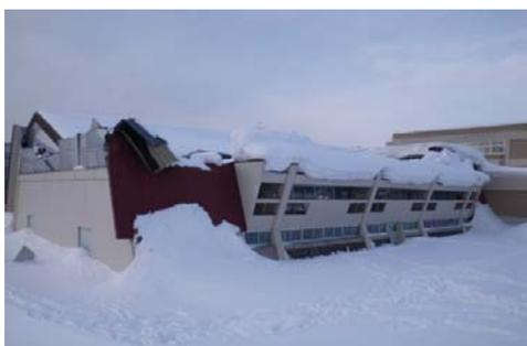
図-7 鉄骨造体育館の倒壊被害(旭川市)
