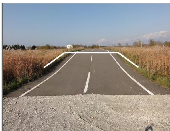
写真-1 試験用盛土道路(盛土高さ約 1.5 m)
